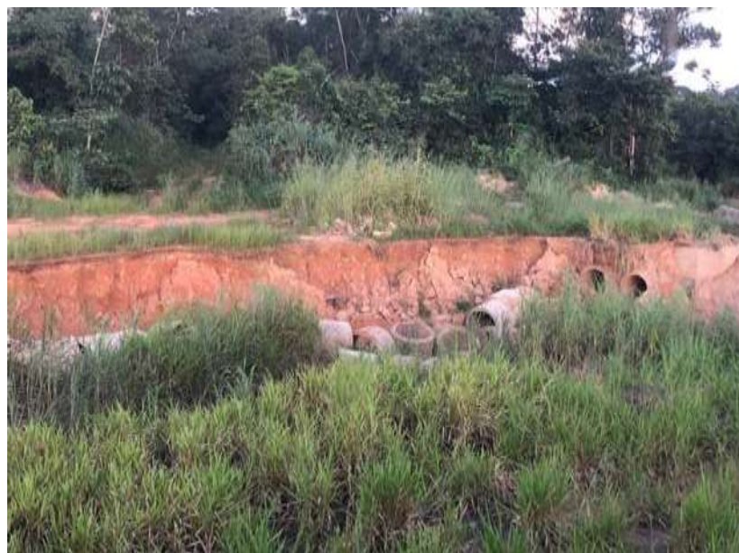
Figura 7 – Reconstrução parcial do coletor norte.
