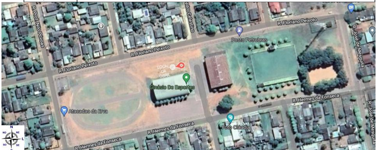
Figura 1 - Localização do Gerador Fotovoltaico.
