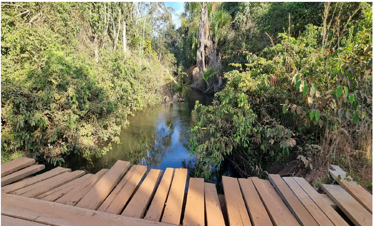
Figura 26 – Ponte sobre o Ribeirão Mil e Um ( 11^{\circ}14'42.80''S / 54^{\circ}54'10.25''O )
